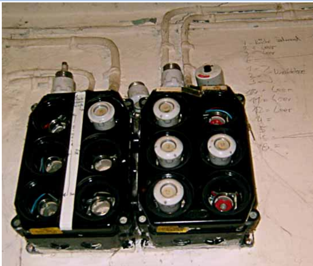
Solche alten Sicherungen finden sich in weit mehr Kellern als man vermuten sollte. Ein Austausch gegen einen modernen Sicherungskasten ist da nur ratsam.
